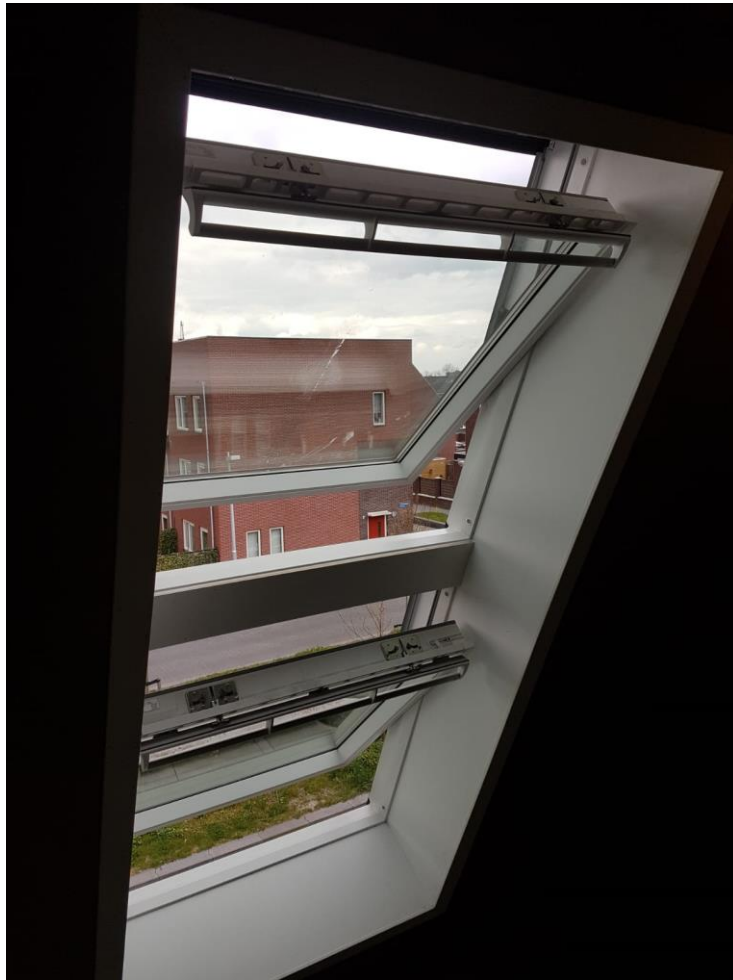
2 verticaal gekoppelde dakramen
