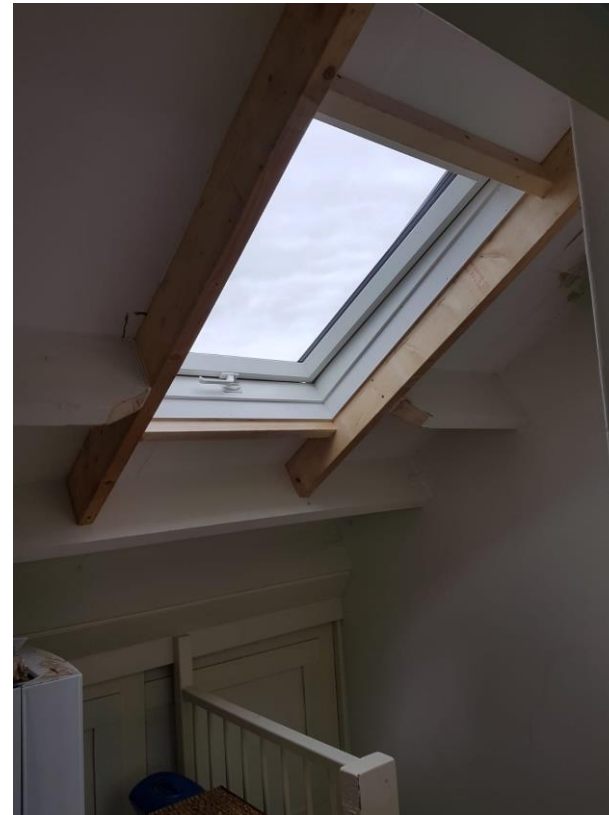
Los dakraam, gordingen doorgehaald en opgevangen
