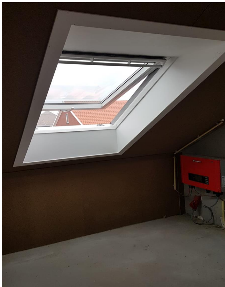
Los uitzet-tuimeldakraam, boven en onder schuin afgetimmerd
